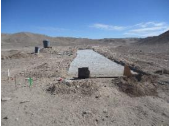
Foto N° 01 Início Obras Sector B. Obra de Arte TPR-10
